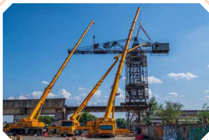
Démontage de la flèche de la grue noire de Nantes, construction métallique de 110 tonnes.
