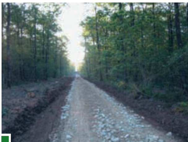
Voie empierrée accessible aux grumiers
