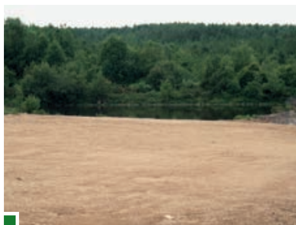
■ Point d'eau DFCI avec plateforme d'accès pour véhicules de secours (forêt de Molac -56)
