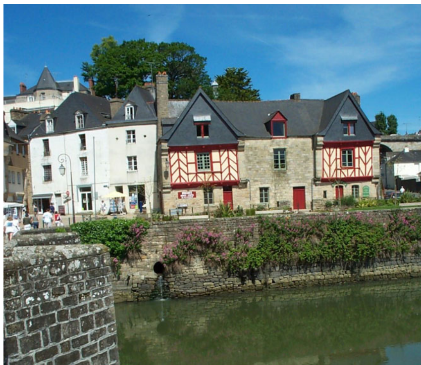
Rejet dans le Port de Saint-Goustan Auray - Photo : J.-P. Allenou
