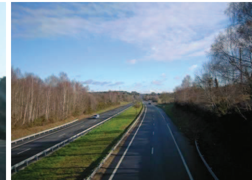
La RN 24 qui traverse le Pays d'Est en Ouest
