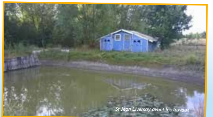
St Jean Liversay bâti avant les travaux
