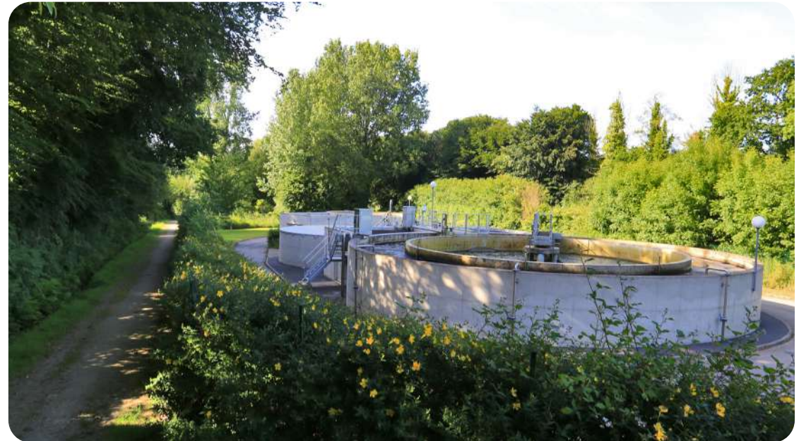
Station d'épuration de Landéda
