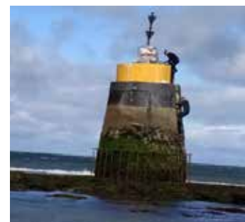
Réparation d'une tourelle dans le Morbihan
