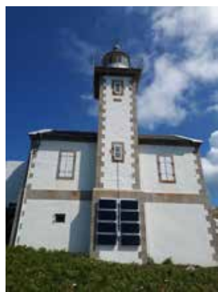
Solarisation de la maison feu du Toulinguet dans le Finistère, source de fiabilité et d'économies
