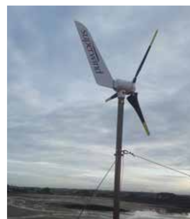
Production électrique pour le phare de l'île Wrac'h
