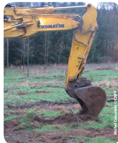
Travail du sol avec godet sur pelle.
