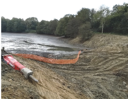
Barrage de Montafilan pendant les travaux en octobre 2017
