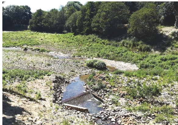
Barrage de Montafilan après les travaux en juillet 2018
