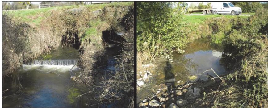
Rampe d'enrochement sur le Chiffrouët - Crédits photo Lamballe Terre et Mer
