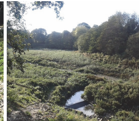
Barrage de Montafilan après les travaux en octobre 2018
