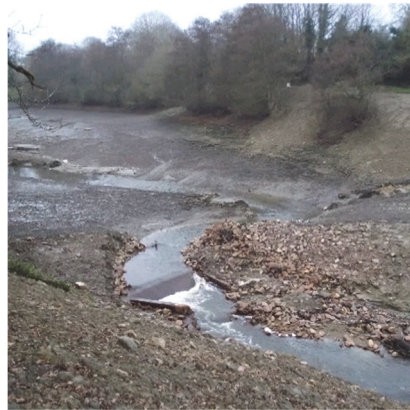
Barrage de Montafilan après les travaux en janvier 2018
