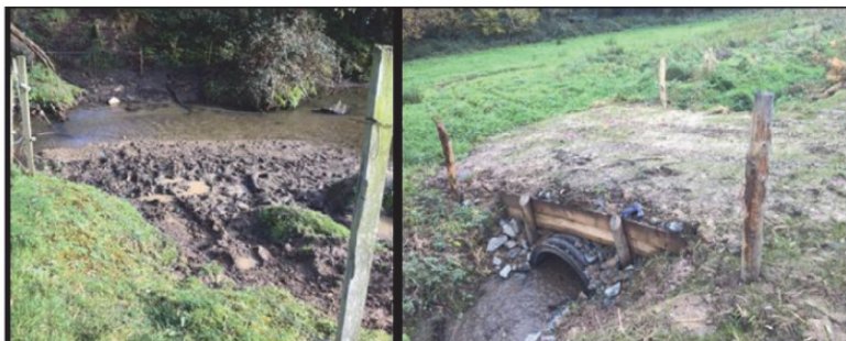
Photos : exemple de divagation d'animaux dans le cours d'eau et pose de demi-arche PEHD en tête de bassin versant (Petit Moulin) - 2017
