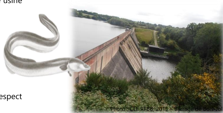
Photo : CLE RFBB, 2015 – Barrage de Bois-Joli
