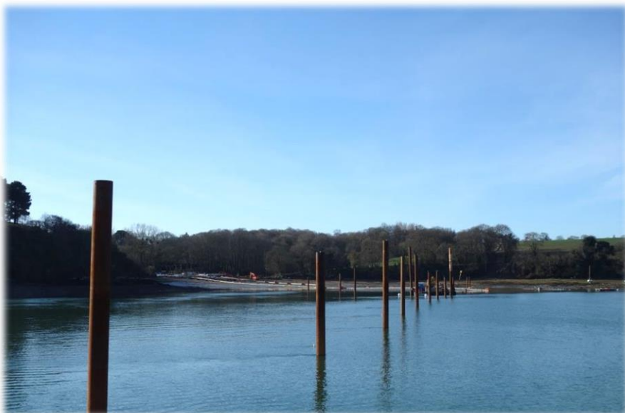
Doublement de la canalisation de transport d'eau potable sous la Rance maritime.
