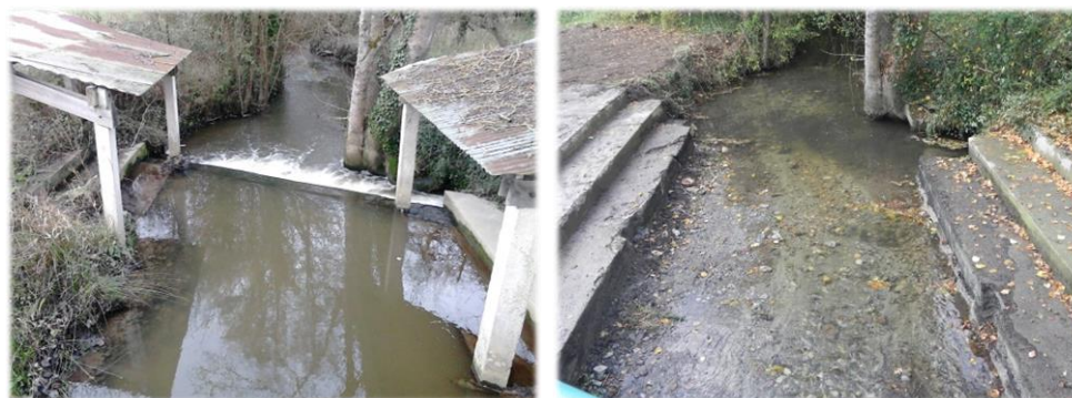
Le lavoir avant et après travaux (COEUR Émeraude)
