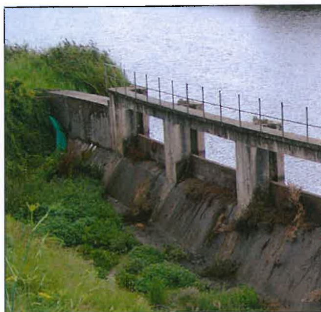
FIGURE 10: VUE AVAL DU BARRAGE DE PONT AVET AVEC SA PASSE A ANGUILLES (FISH PASS)
