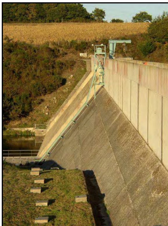
FIGURE 14 : VUE DE L'ASCENSEUR A ANGUILE DU BOIS JOLI. (FISH PASS)
