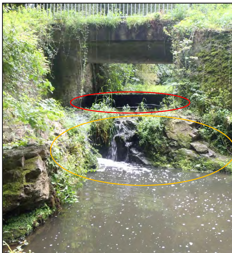
FIGURE 31 : AMONT DU SECTEUR DE MOTTE OLIVET. EN ORANGE, UN SEUIL NATUREL. EN ROUGE, UN SEUIL ARTIFICIEL NON EQUIPE (FISH PASS).
