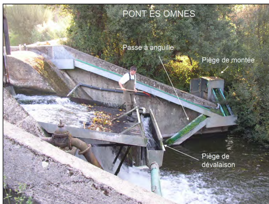
FIGURE 13 : PASSE ET PIEGES SUR LE BARRAGE DE PONT ES OMNES (FISH PASS).
