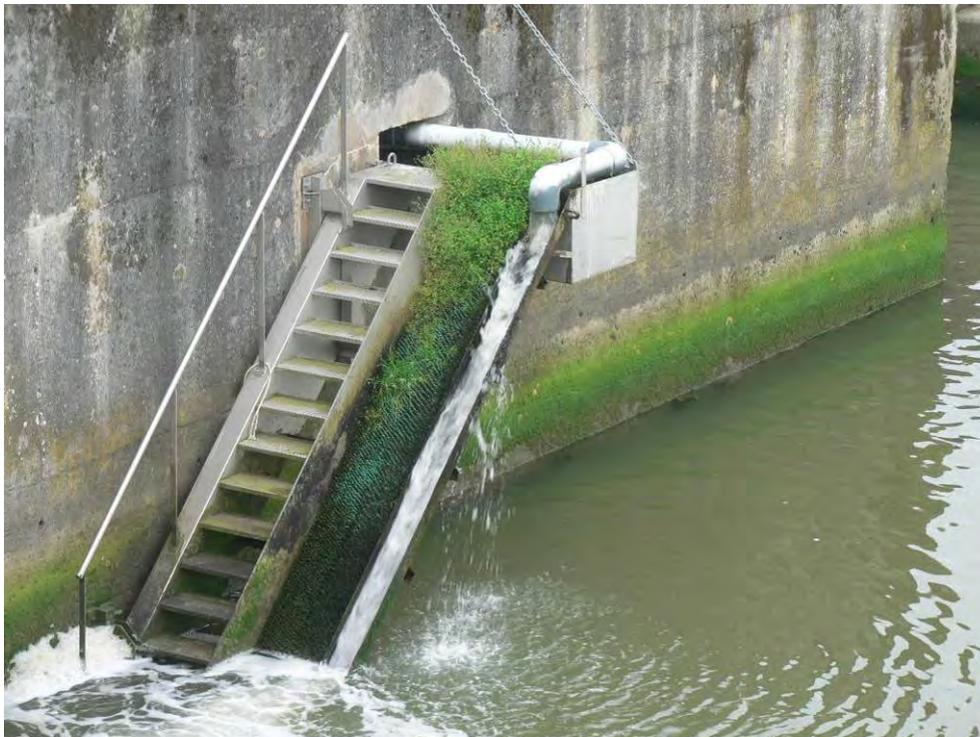
Figure 2.- Passe à anguilles (côté gauche de la passe à bassins).
