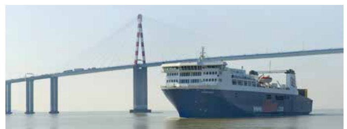
► Ferry sous le pont de l'Atlantique © Medde, Laurent Mignaux, 2011
