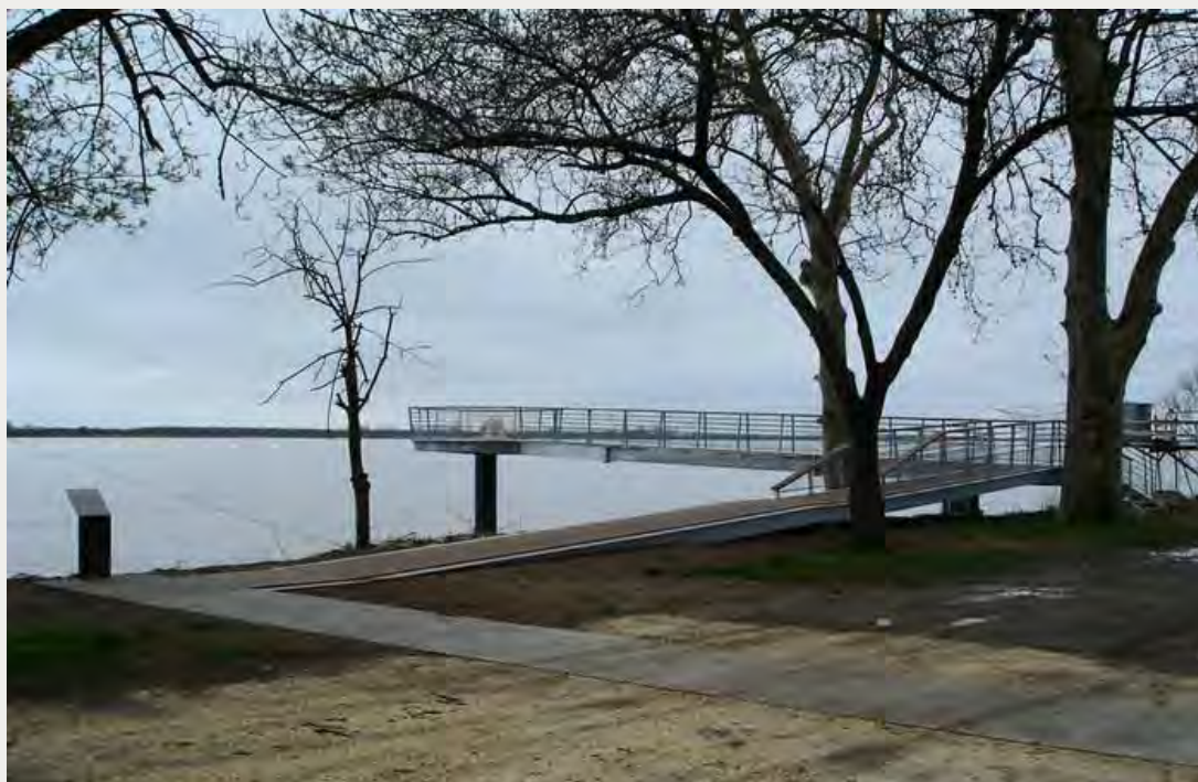
Site de la Roque de Thau, à Villeneuve. Ponton au-dessus des eaux de la Gironde.
