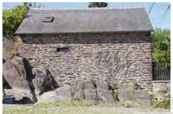
Ancienne carrière de schiste à Pont-Réan. Affleurement de schiste et maison construite avec des moellons de schiste au Boël, à Pont-Réan.
