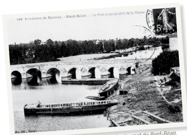
Chantier de construction de cahot, près du pont de Pont-Réan, début du 20 e siècle.
