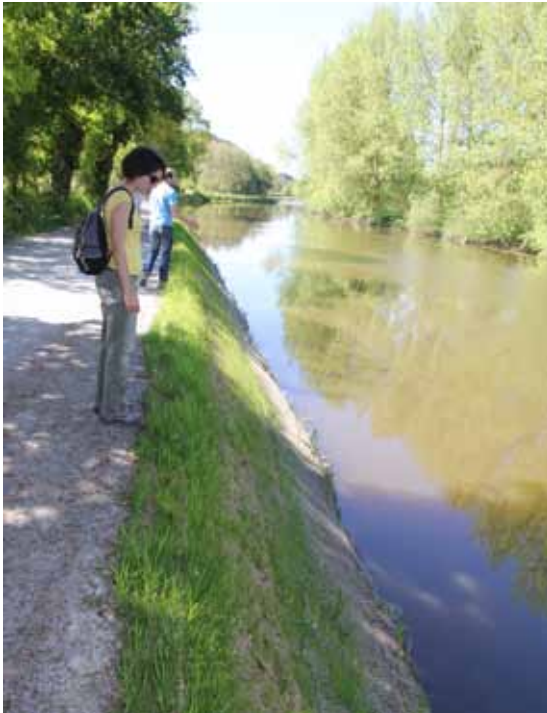
Génie écologique pour la consolidation des berges de la Vilaine, Pont-Réan.
