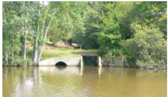
Les ouvrages constituent parfois des freins aux continuités biologiques.
