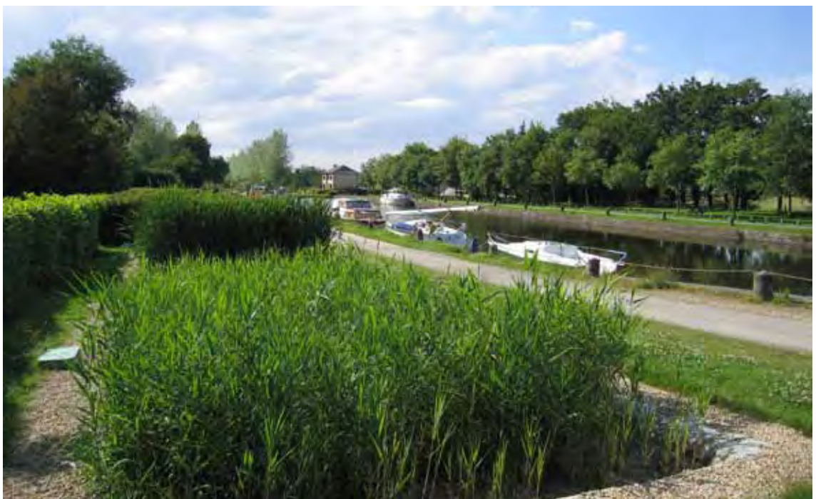
Philtre plantée, assainissement autonome de la maison éclésièrre, de toilettes publiques et de la batellerie de Bazouges-sous-Hédé.
