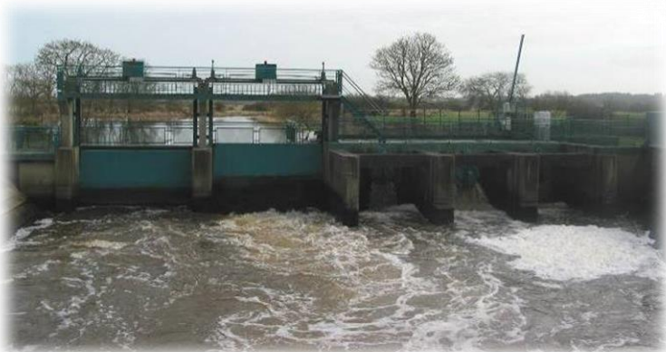
Fig 28 : Barrage de l'Isac à sa confluence avec la Vilaine
