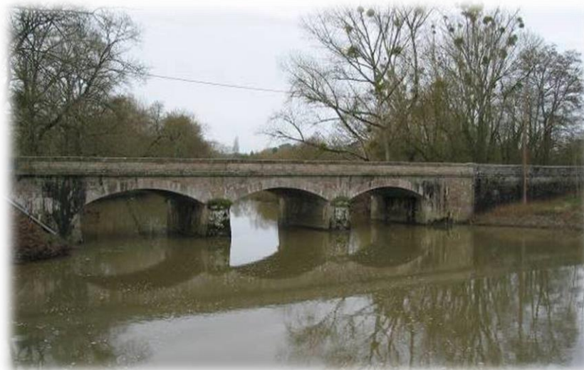
Fig 30 : Pont sur le Don (Guéméné Penfao)
