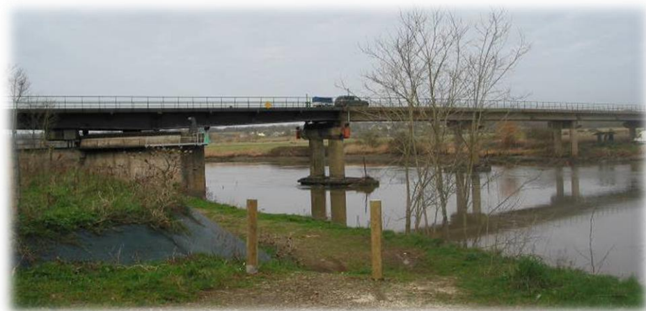
Fig 33 : Pont mobile de Cran
