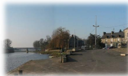
Fig 23 Port de Guipry-Messac
