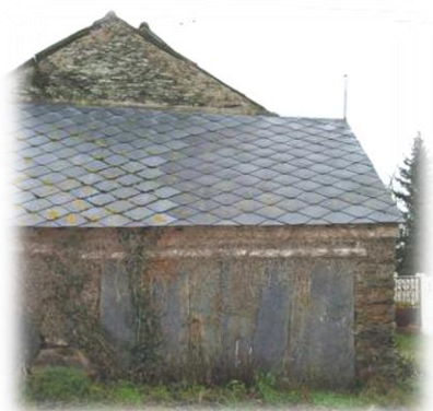
Fig 60 : Bâtiment avec palis
