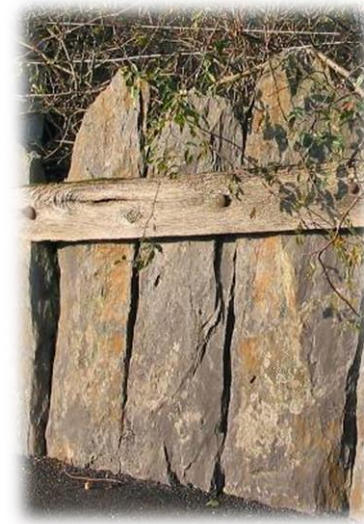
Fig 11: Clôture en palis
