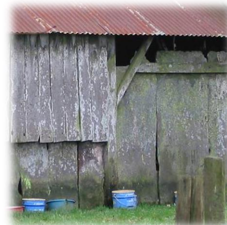
Fig 12 : Soubassement et mur en palis
