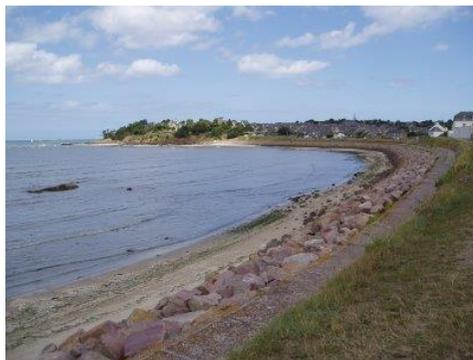
Figure 97 : Ouvrage de protection contre le risque d'érosion marine (Source : Mairie de Saint-Jacut-de-la-mer)
