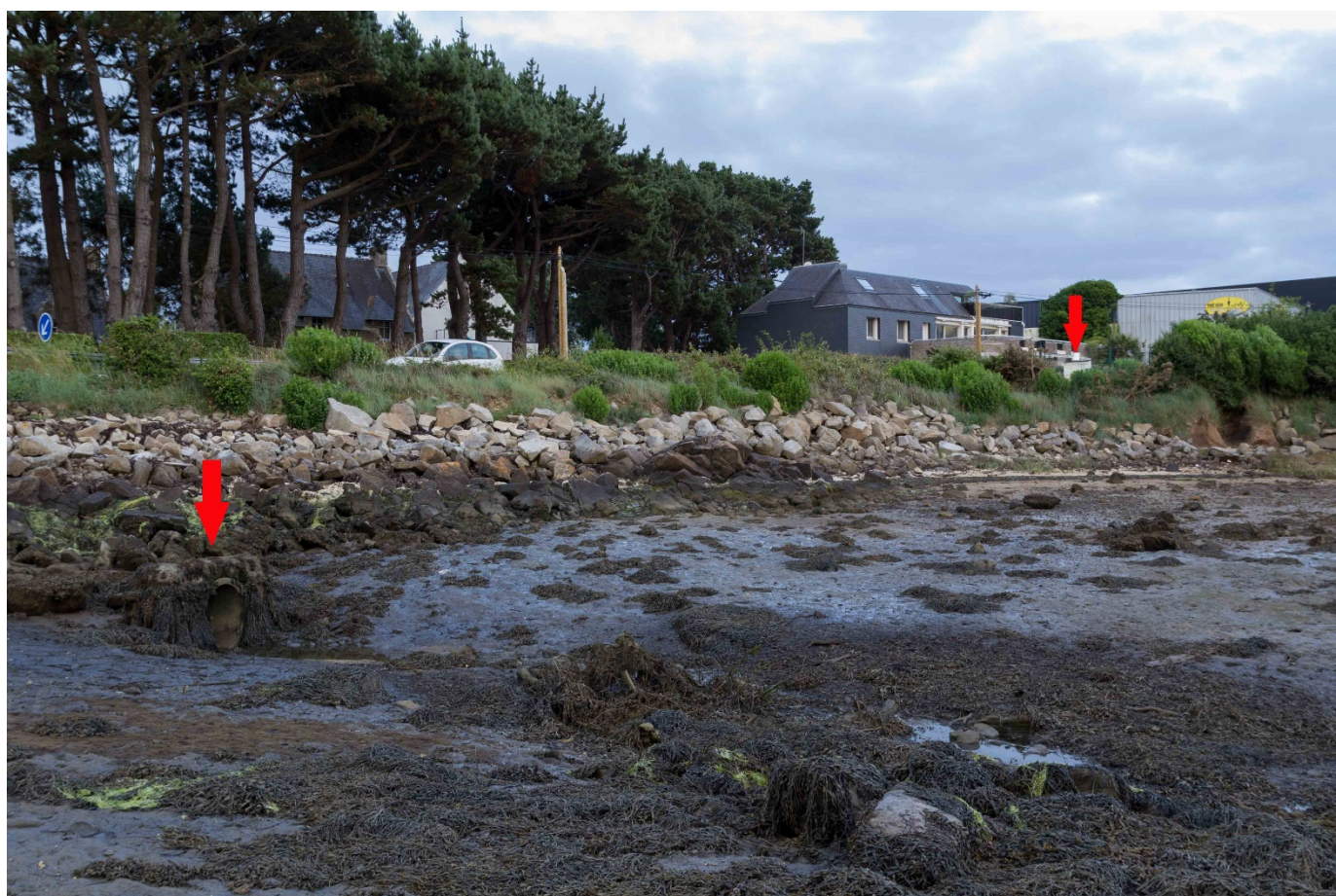
A gauche le fameux exutoire dans la rivière de Crac'h et à droite la station de relevage de Port Deun
