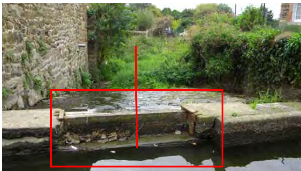
Aménagement d'une vanne de fond/de décharge au droit du déversoir vers le bras sud
