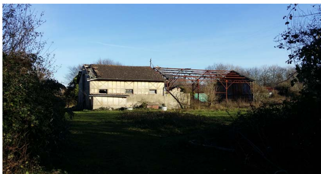
Le terrain d'assiette du second projet, où subsistent les ruines d'anciens bâtiments agricoles (Photos : O. Lozachmeur).
