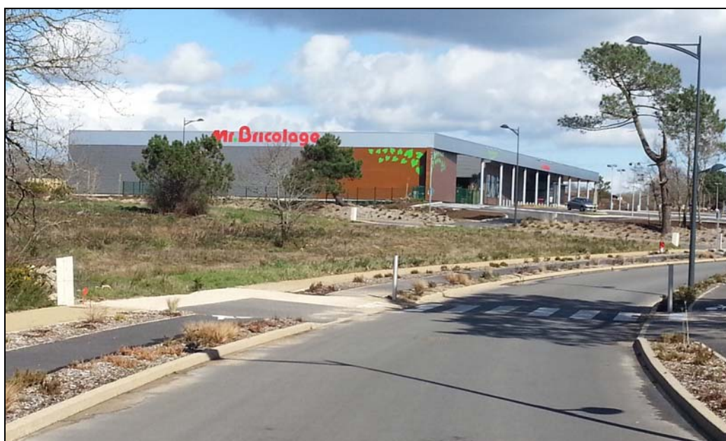
Le premier bâtiment construit dans la nouvelle partie de la zone d'activités (printemps 2013).
