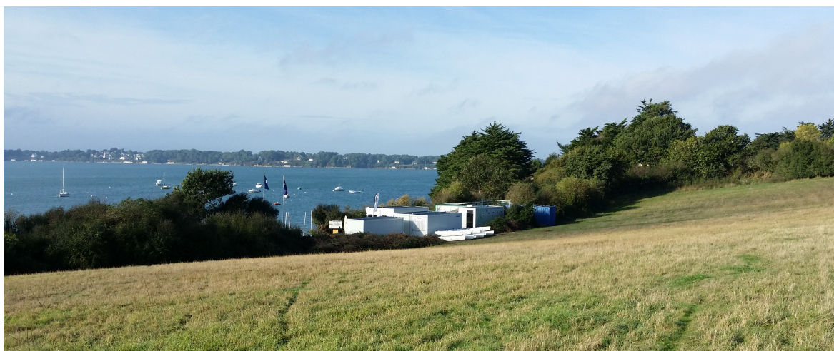
Les installations du centre nautique existant, en espace «remarquable» (CAA de Nantes, 28 juin 2013, Commune de Baden, n°11NT02579).
