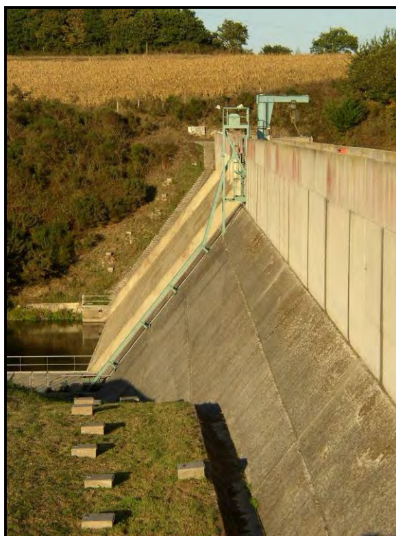
FIGURE 13 : VUE DE L'ASCENSEUR A ANGUILE DU BOIS JOLI. (FISH PASS)
