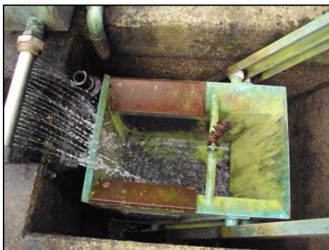
FIGURE 65 : ASCENSEUR DE BOIS JOLI APRES RUPTURE DU CABLE
