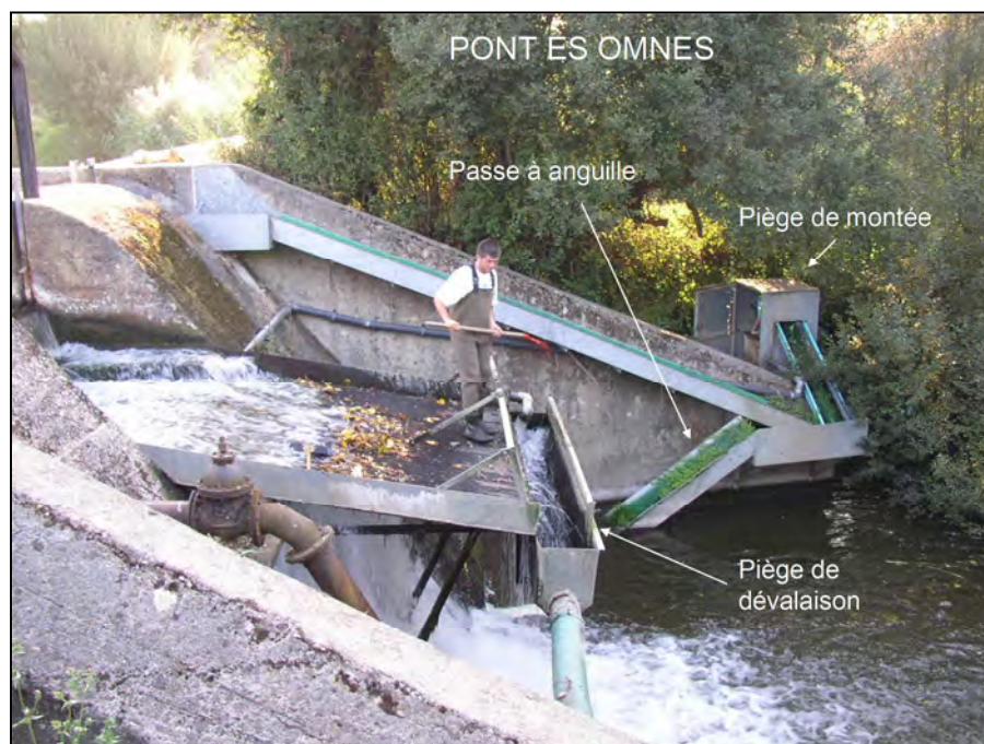
FIGURE 12 : PASSE ET PIEGES SUR LE BARRAGE DE PONT ES OMNES (FISH PASS).
