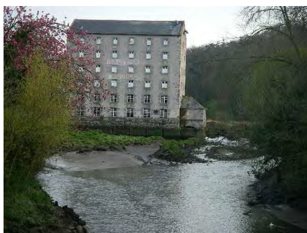
Vue aval du Moulin
