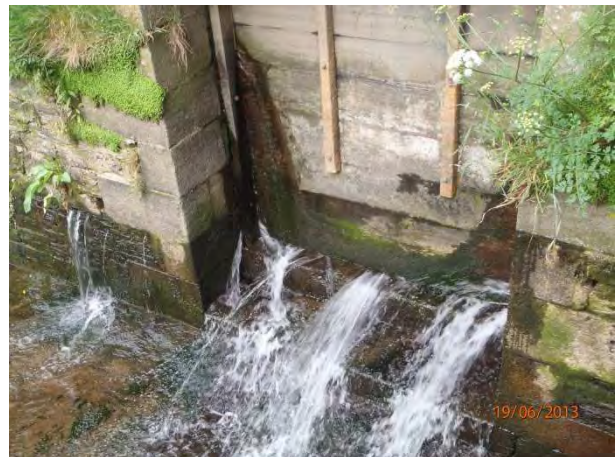
Pertuis usinier gauche (prise d'eau et vanne de décharge)
