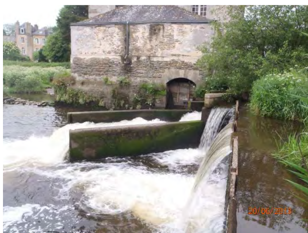
Vue des ouvrages de décharge
