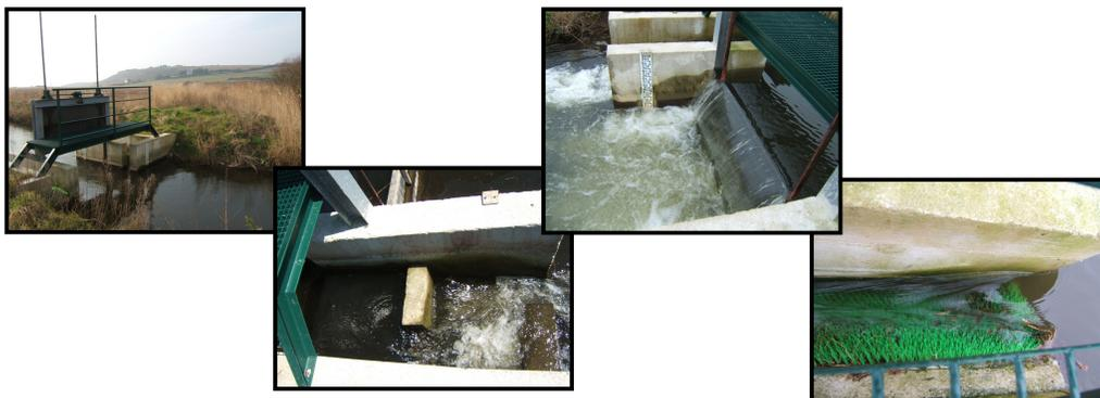
Les vannes métalliques présentent une largeur de 2,00 mètres en intérieur de cadre. Elles sont équipées de deux panneaux télescopiques, pouvant glisser l'un par rapport à l'autre. Elles sont commandées par deux crics à crémaillère avec boîtier de commande central. Les vannes permettent une variation de la hauteur d'eau barrée comprise entre 0.70 m et 1.10 mètres. Quatre échelles limnimétriques de 1,50 mètres ont été installées en amont et en aval de chaque ouvrage, pour le suivi des débits.
