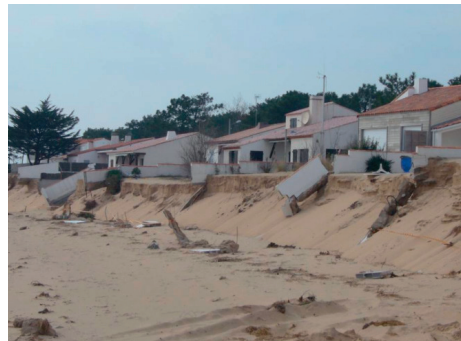
Figures B13 – Exemples de reculs dunaires consécutifs à la tempête Xynthia. À gauche : recul d'environ 8 m à Saint-Jean-de-Monts. À droite : recul ayant causé l'endommagement de maisons situées en première ligne à la Tranche-sur-Mer.
