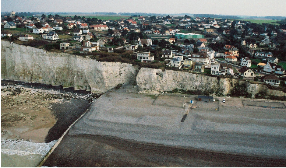
Figure C14 – Impact d'un épi entraînant d'un côté une accumulation limitant l'action marine au pied des falaises et de l'autre l'accentuant
