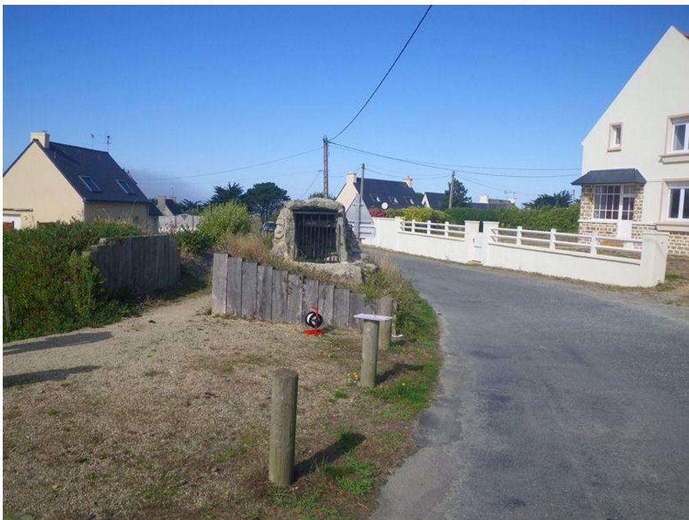
Photographie du puits n°2 situé au lieu-dit Landévennec à Plouguerneau lors de la visite du 01/10/2014 (Source : BRGM)
