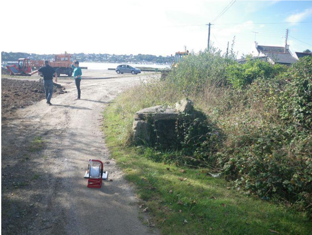
Photographie du puits n°1 situé au lieu-dit Perroz à Plouguerneau lors de la visite du 01/10/2014 (Source : BRGM)
