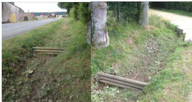
Figure 8 : Canal à ciel ouvert drainant les eaux du parking, vue amont (gauche) et vue aval (droite)
