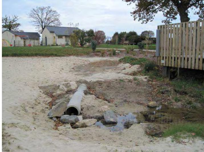
**Figure 9 : Arrivée de l'eau pluviale sur la plage (exutoire 2)**
