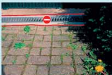
Avaloir au bas d'une pente de garage
