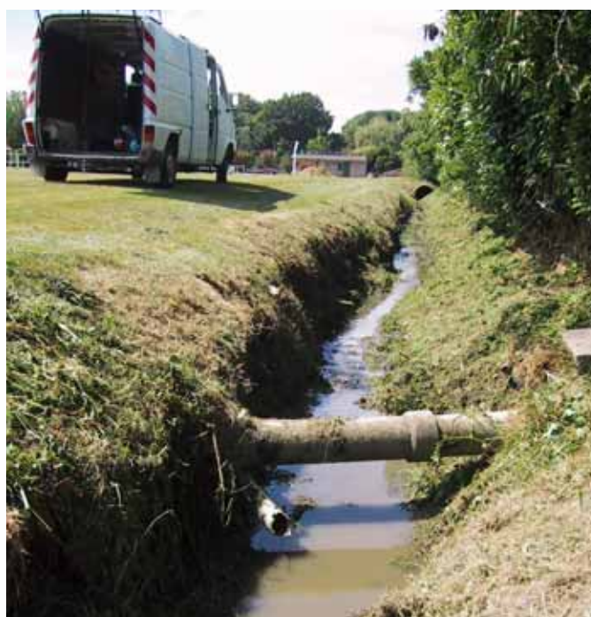
Sortie des drains du terrain de sport
