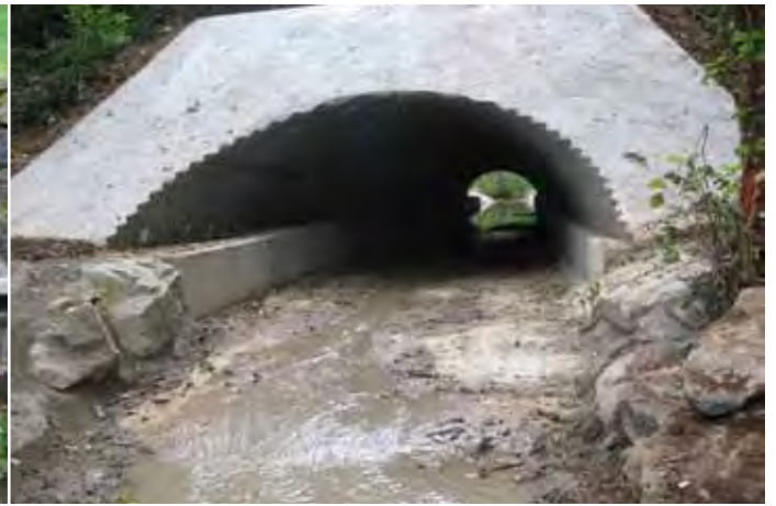
Banquette béton sous un ouvrage de grand gabarit
