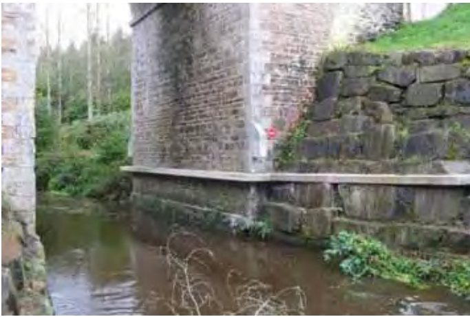
Exemples de banquettes béton aménagées sous des ouvrages existants Banquette béton en encorbellement. Coût : 350 – 375 €/mètre linéaire
