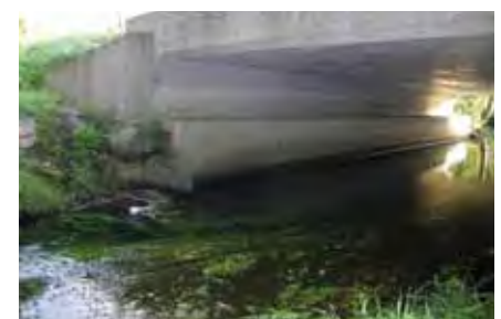
Ci-dessus, banquette le long du cours d'eau
