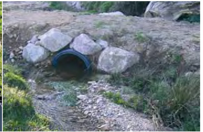
Arche polyéthylène en place sur cours d'eau
