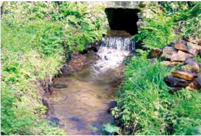
Obstacle avant aménagement
