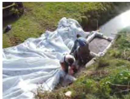
Etanchéification des bassins par géotextile
