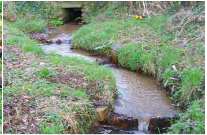
Obstacle aménagé avec pré - barrages en pierre
