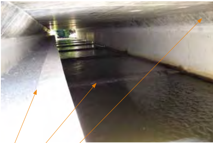
Banquette - déflecteurs - pont cadre
