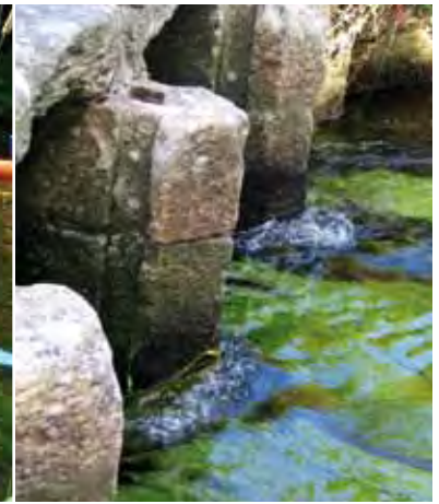
Ouvrage à intérêt patrimonial (pont en pierre avec chute)
