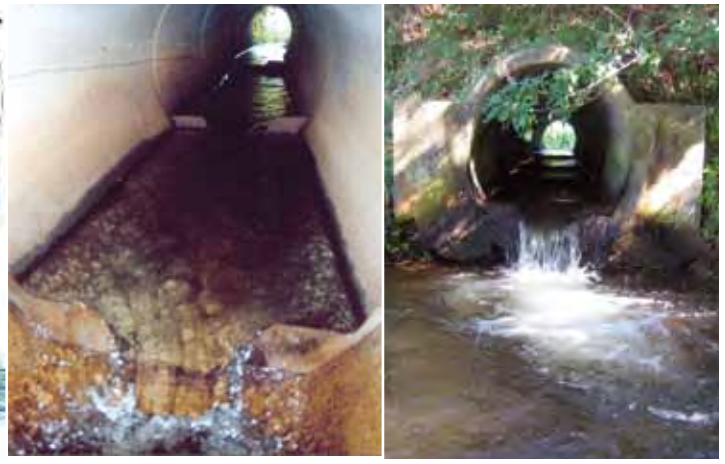
Déflecteurs posés dans une buse
