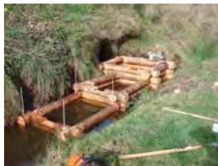
Buse aménagée par bassins en bois (mélèze) pré-construits en hangar puis démontés et remontés sur site
