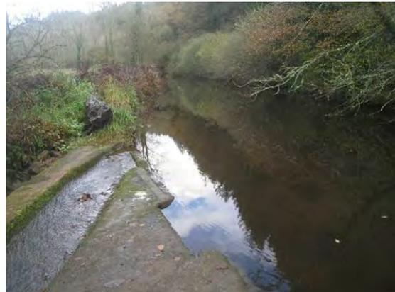
Contraste entre zone influencée et zone non influencée : le Steir à Plogonnec, Ster ar C'hoat, La zone influencée en amont de l'ouvrage transforme le « cours d'eau » en quasi plan d'eau.
