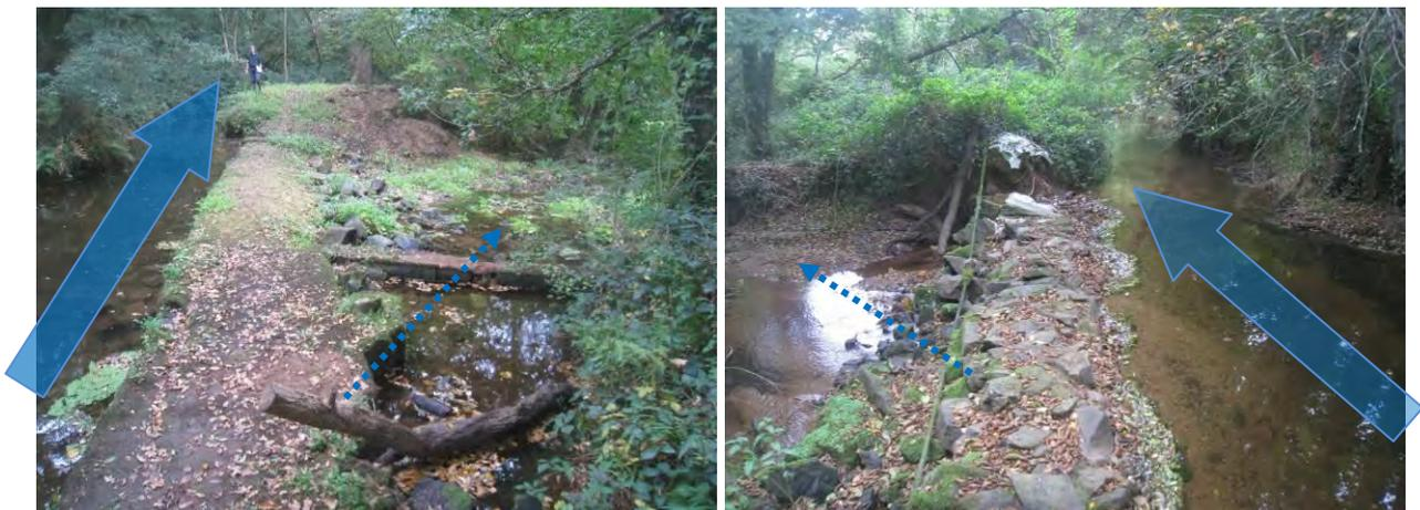
*Problématique des débits réservés : sur ces photos les configurations des ouvrages conservent en étiage la majeure partie du débit sur le bief ; le cours d'eau est uniquement alimenté en tant que bras de décharge, voire même uniquement du fait du mauvais état des maçonneries*
