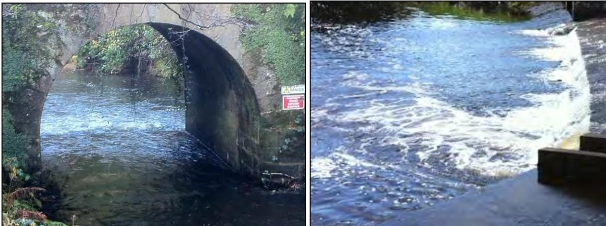
Sur la photo de gauche (Stang Luzigou, Odet), la problématique en cause n'est pas la hauteur de chute mais surtout la faible lame d'eau sur le radier aux basses eaux, qui rend l'obstacle difficilement franchissable pour les poissons nageurs (lamproie, alose) et sauteurs (saumon, truite).
