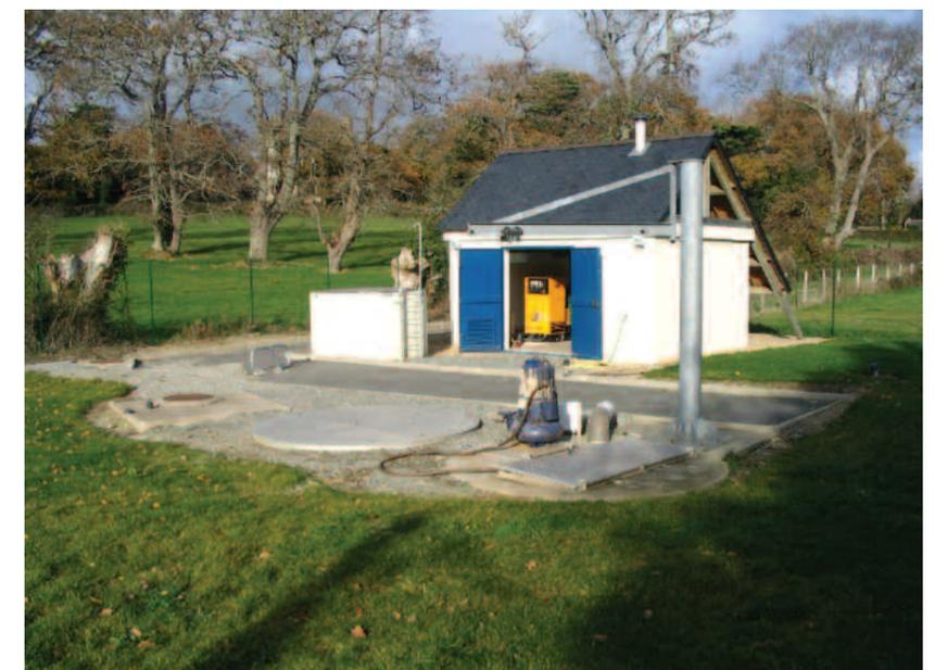
Porte de relèvement de Penmeil – Groupe électrogène, pompe, réservoir tampon
