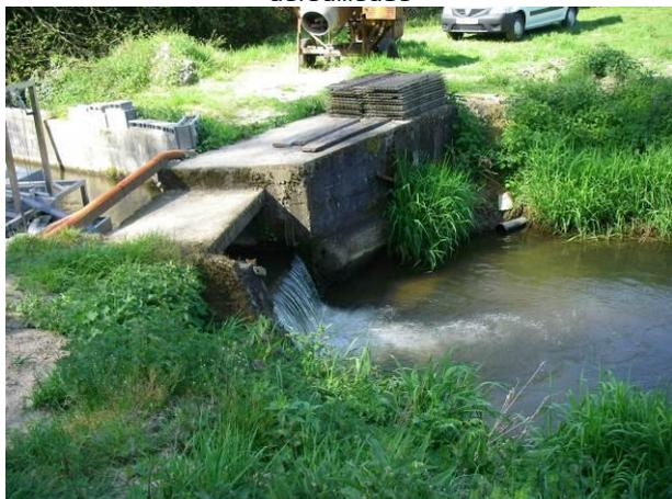
*Vue du batardeau permettant le déversement vers le bassin intermédiaire avant la passe à poisson*
