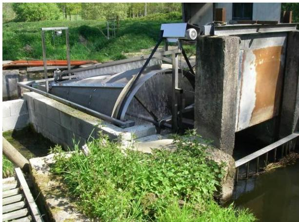
*Vue amont du canal de prise d'eau : grille de protection, vanne pour la maintenance et défeuilleuse*
