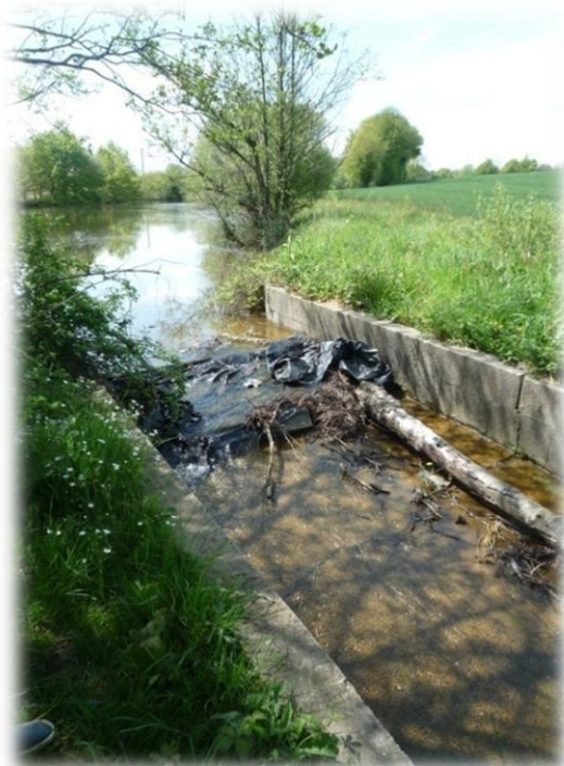
Figure 20 : Photographie d'un cours d'eau complètement chenalisé, même le fond est artificialisé. Source : Remi Nguyen Van
