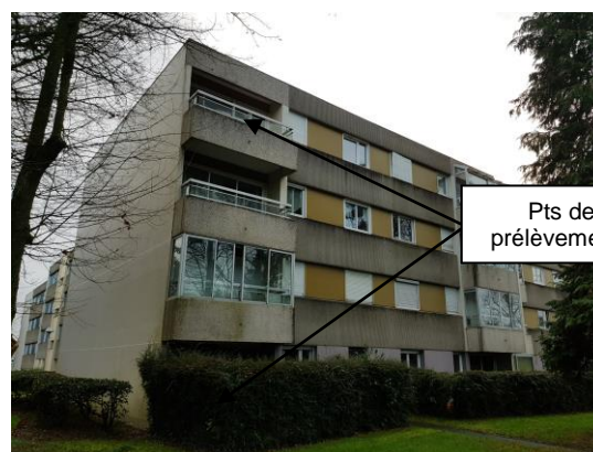
Figure 37 : façade côté rocade - exemple de l'immeuble 20
