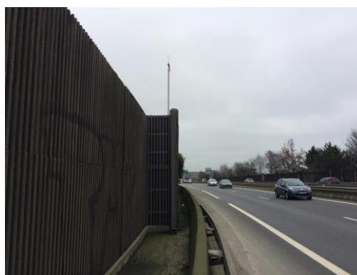
Mur antibruit séparant la voie des habitations
