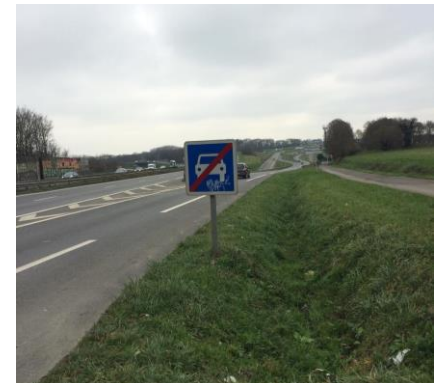
Axe routier au même niveau que son environnement
