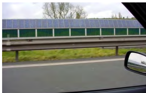
Mur anti-bruit photovoltaïque sur l'autoroute A21 près de Lens
