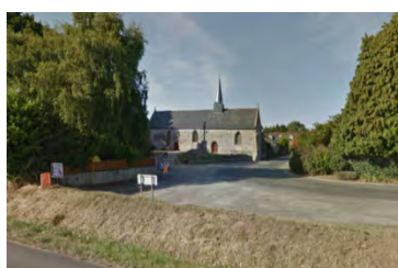
N165/E60, Chapelle Notre-Dame du Rohic, Rohic (Vannes)
