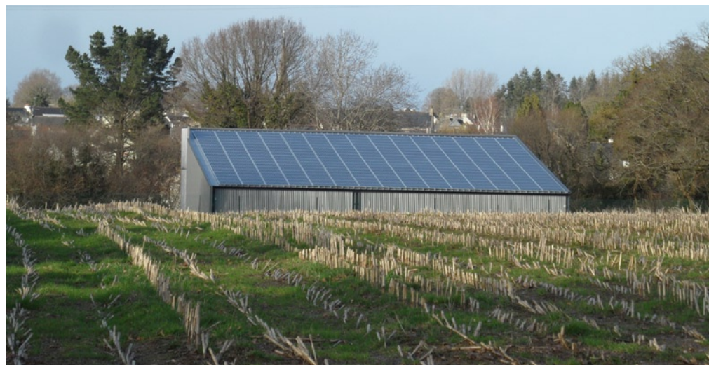
Panneaux photovoltaïques sur un bâtiment agricole à Lignol.
