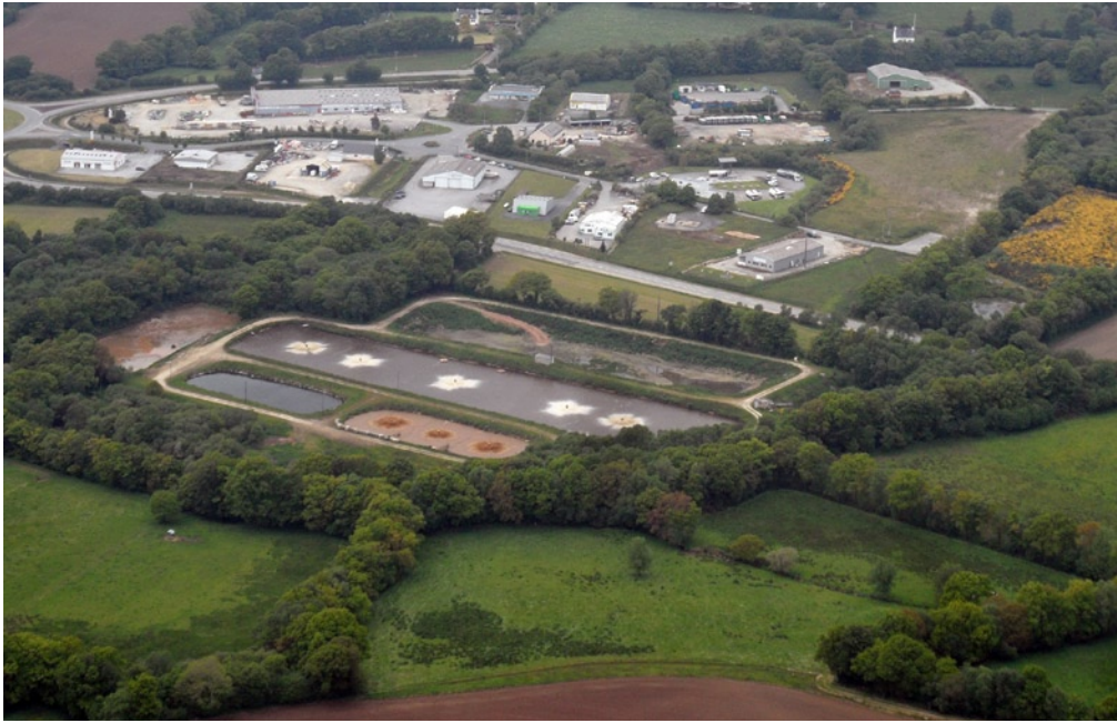
Station d'épuration de la zone industrielle de Gourin.
