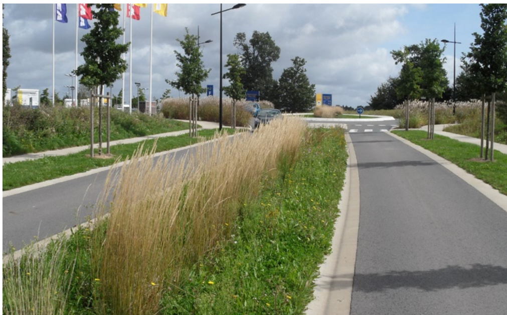
Chaussée avec dispositifs d'infiltration des eaux pluviales dans une zone commerciale.
