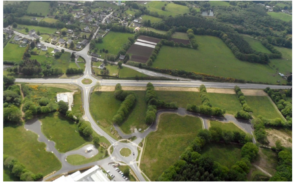
Les réaménagements de carrefours le long de la D 769 ont contribué à réduire la mortalité routière sur cet axe. Ici, giratoire de Restalgon au Faouët.
