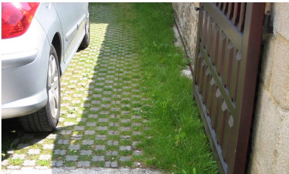
Stationnement privé avec matériaux permettant l'infiltration des eaux pluviales.
