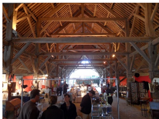
Brocante d'août sous les halles du Faouët.
