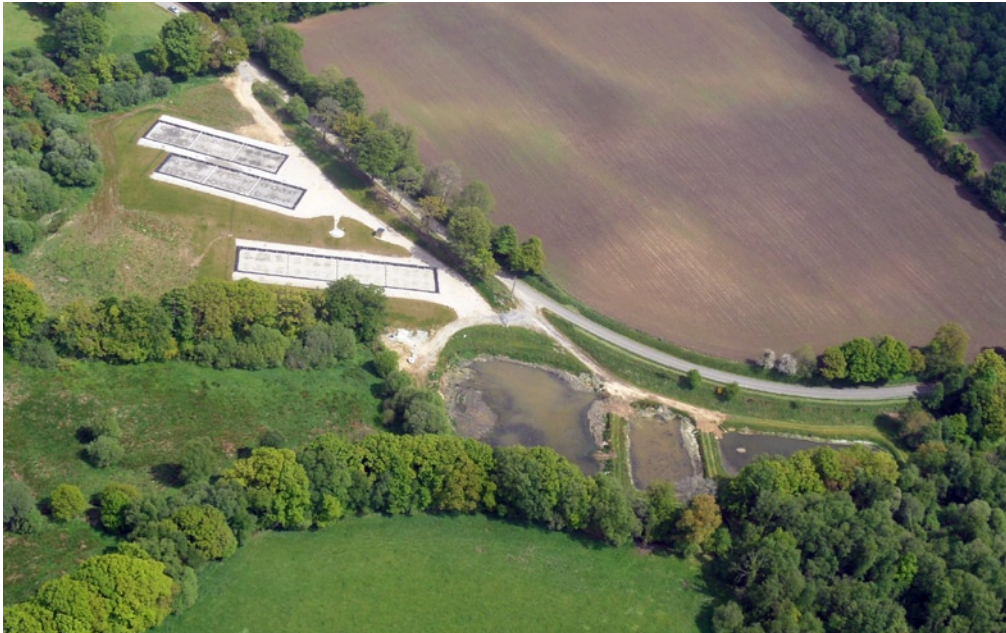
Un nouveau dispositif d'épuration, de type filtres plantés de roseaux, a remplacé en 2013 l'ancien système de lagunage au bourg de Saint-Tugdual.
