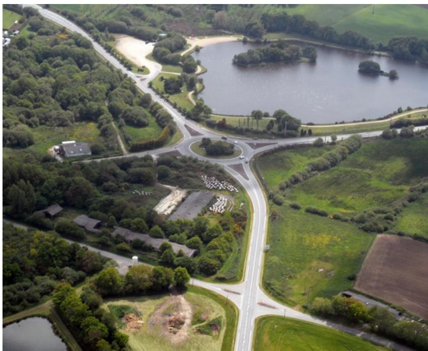
Modernisation du réseau routier : la D 790 à Plouray.
