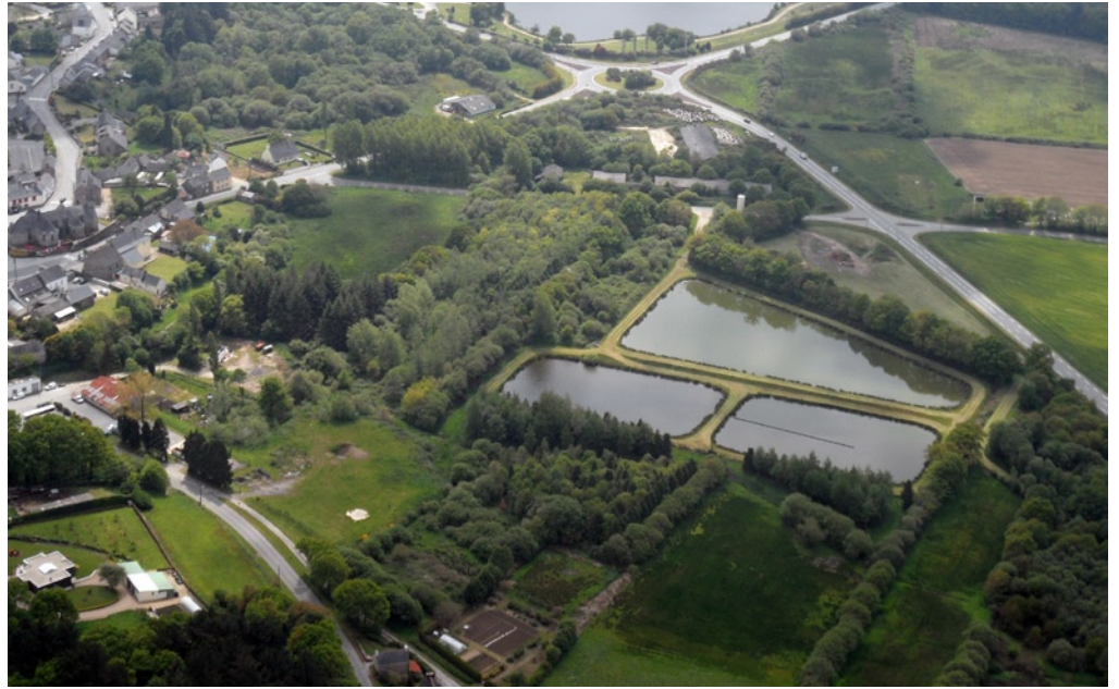
Station d'épuration à Plouray.
