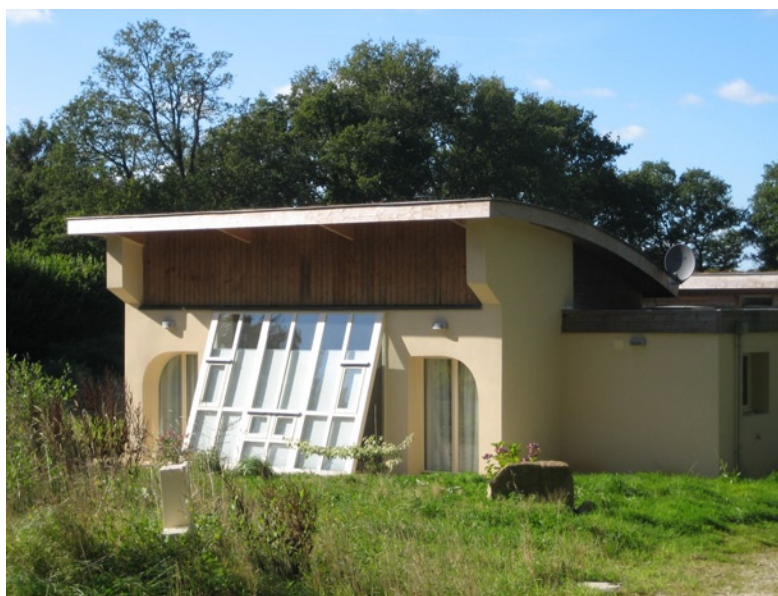
Capteurs solaires à Plouray.
