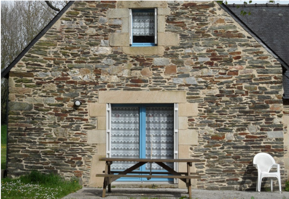
La géologie du territoire se lit dans l'architecture : construction en schiste ardoisier et quartzite, encadrements d'ouvertures en granite (Tronjoly à Gourin).
