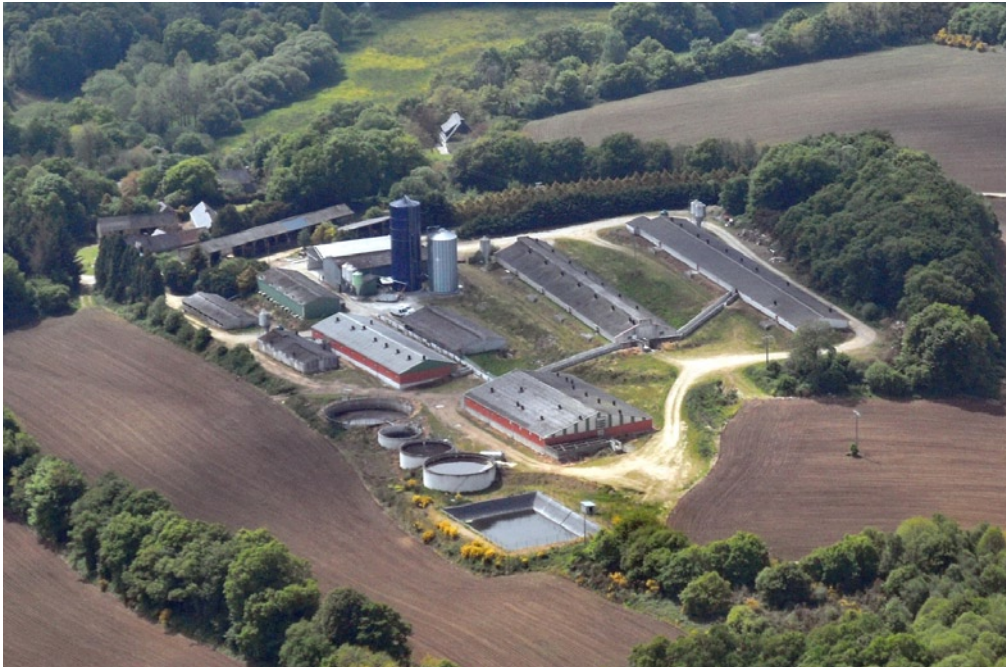
Dispositifs de collecte des effluents dans une porcherie à Priziac.
