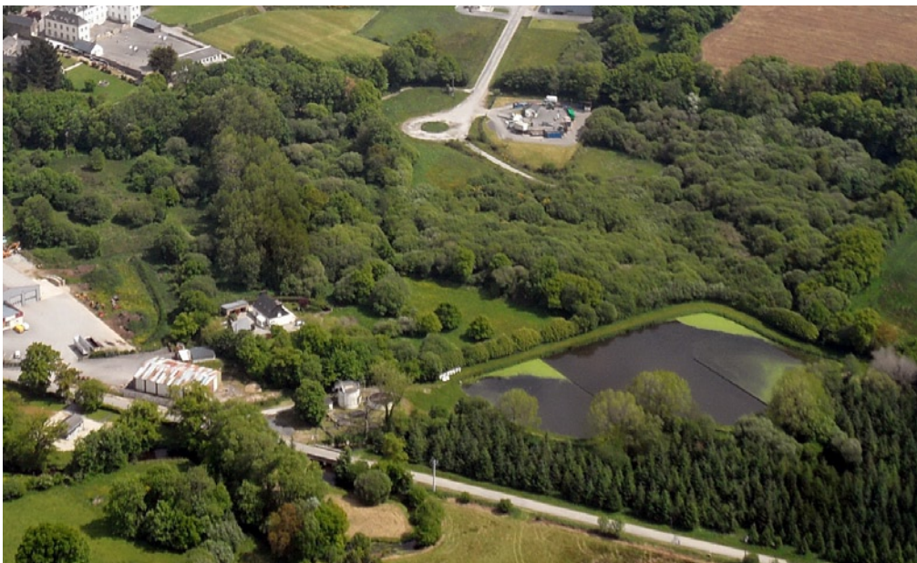
La station de Guéméné-sur-Scorff s'est révélée sous-dimensionnée en 2014.
