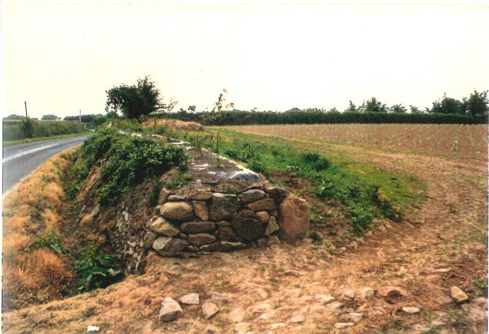
Exemple d'une reconstitution d'un talus grâce aux aides départementales.
