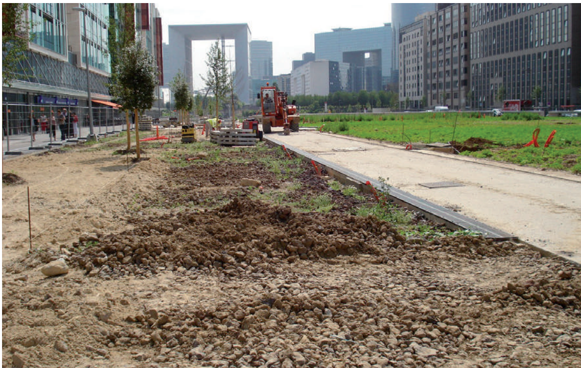
Aménagement de la ville : les Terrasses de la Seine à l'Arche
