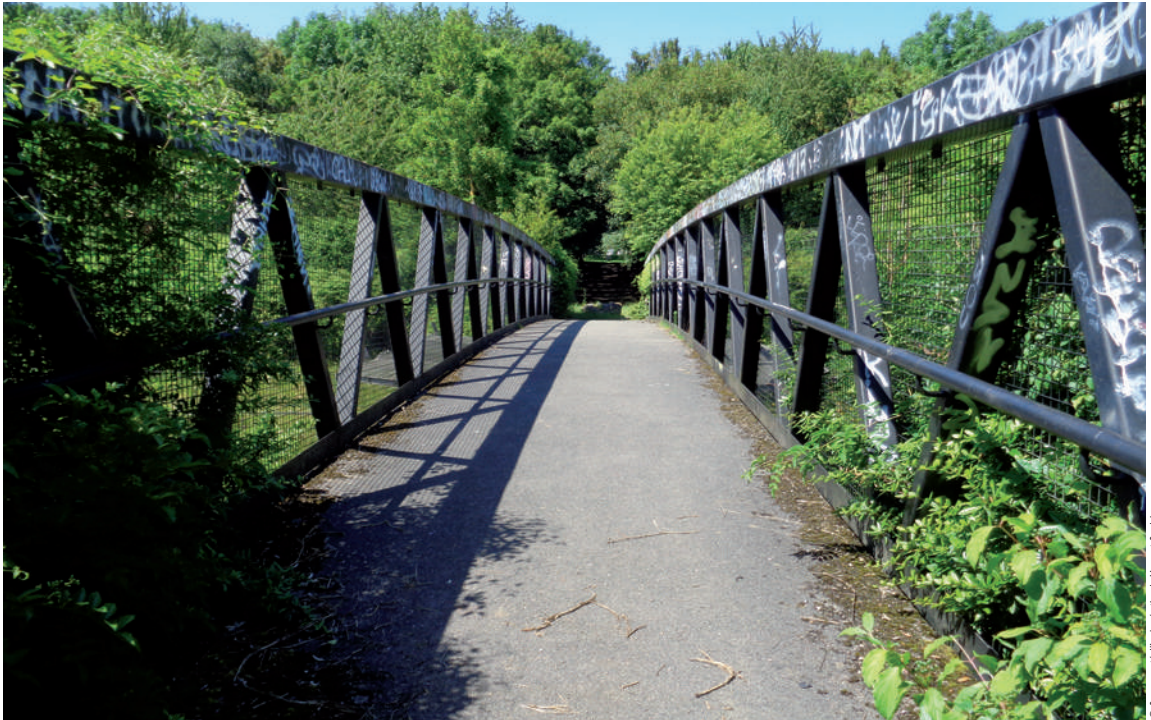
Point de blocage au niveau de la francilienne à Saint-Thibault-des-Vignes
