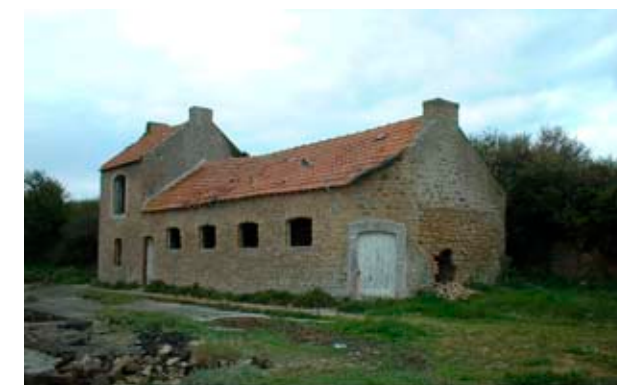
Bâtiment ostréicole désaffecté à Kerivaud
