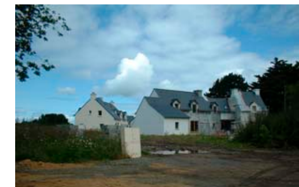
Entrée de Béninz: chantier en cours le long de la RD 198
