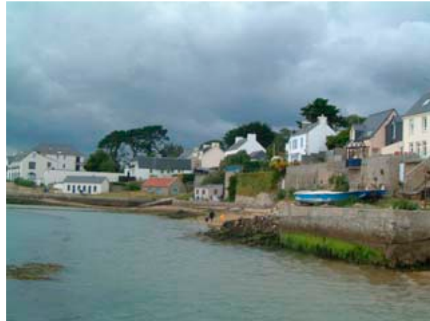
Pen Lannic, pointe est: en recul de la côte, ces constructions permettent de maintenir un cheminement piéton le long du Golfe
