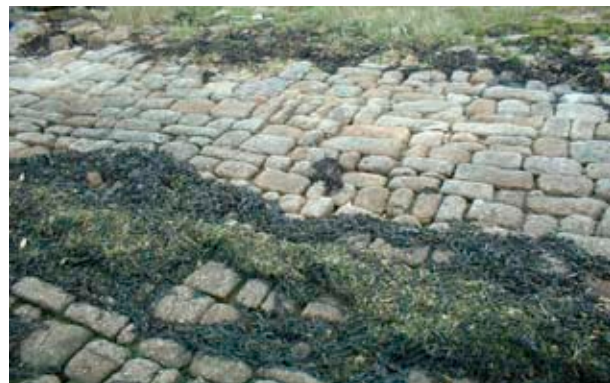
Exemple intéressant d'appareillage de pierres sur une cale: l'ensemble de ces ouvrages doit être répertorié et entretenu
