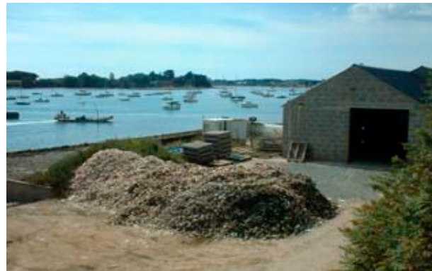
Autre exemple de chantiers ostréicoles peu entretenus...
