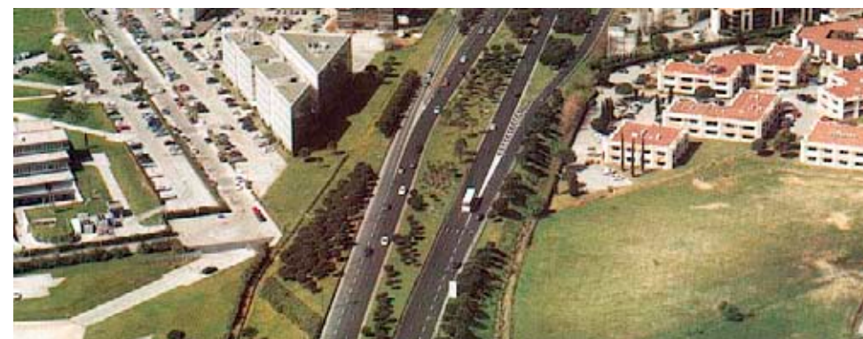
Exemple de requalification de voie rapide: Montpellier (M. Desvigne, paysagiste)
