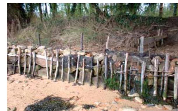
Des ouvrages de protection improvisés mais efficaces
