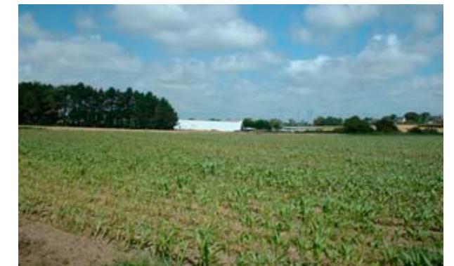
Il en manque peu pour que le chantier passe inaperçu
