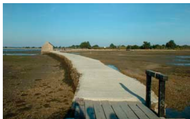
Digue de l'étang du Moulin à l'Île d'Arz
