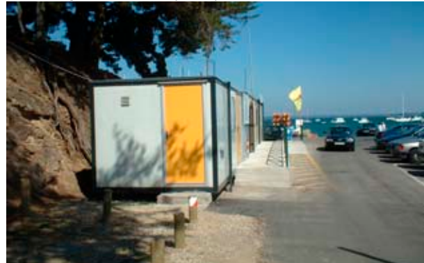
Le bureau du port, douches et WC... du provisoire solidement fondé...
