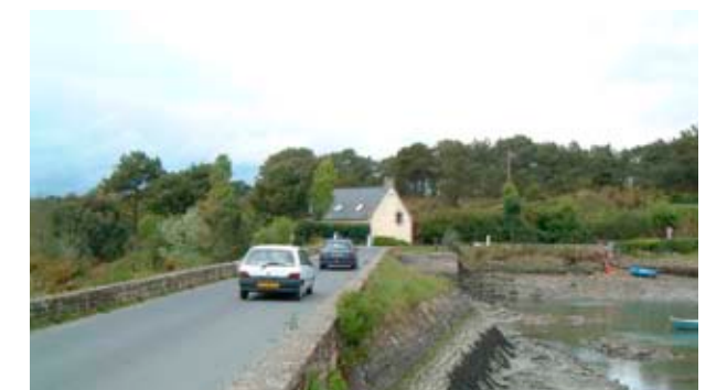
Route en digue: Pen En Toul.
