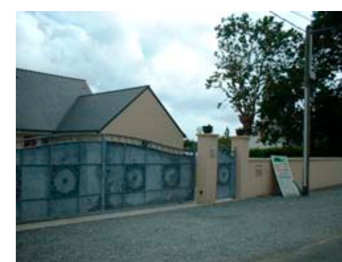
Construction récente mal intégrée
