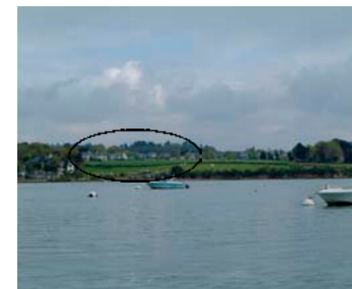
Extension urbaine sur ligne de crête à Arradon (Kervéro)
