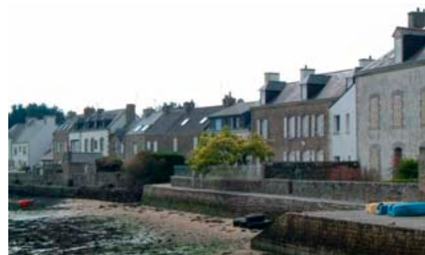
Locmariaquer : une côte architecturée par les ouvrages de soutènement et les pontons
