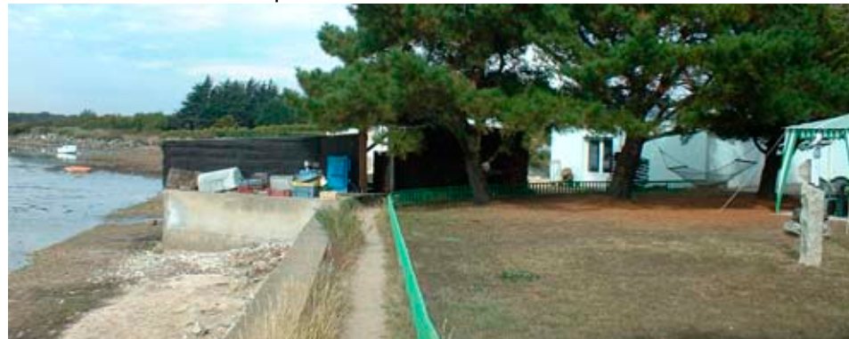
Cadouarn: le chemin passe au fond de la parcelle de l'ostréiculteur et traverse le chantier
