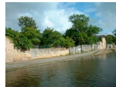
Les quais à fleur d'eau
