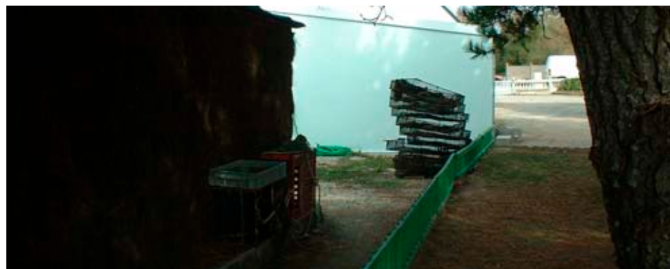
Le passage est étroit mais la place du piéton est clairement définie par une clôture très basse qui ne défigure pas le paysage du chantier
