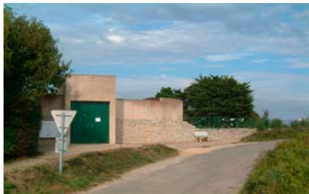
Une signalétique et une entrée peu adaptée à la fréquentation du site
