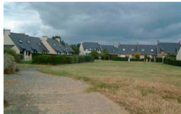
Habitat groupé, Le Paludo (Larmor-Baden): ce lotissement s'est développé à l'arrière du Golfe, dans la continuité de l'ancien hameau du Paludo. Le mode d'urbanisation, l'emplacement, permet de réduire l'incidence de ces constructions.
