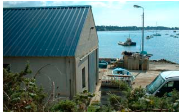
Le minimum nécessaire à la bonne intégration du bâtiment n'est pas respecté ici. On ne peut autoriser ce type de traitement des chantiers sur les rivages du Golfe du Morbihan.
