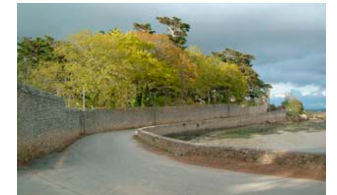
Route "soutènement": BotSpernen
