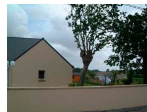
Construction récente mal intégrée
