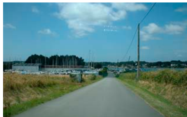
Depuis le hameau, en se dirigeant vers la cale, le chantier est très présent.
