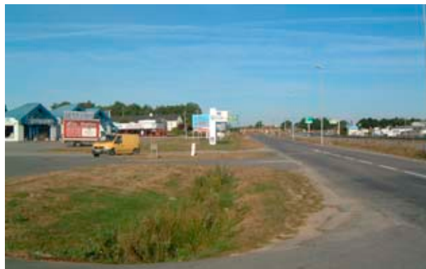
ZA d'Atlantheix: fossés de drainage existants
