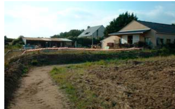
Le chantier marque un barrage au sentier côtier qui doit le contourner.
