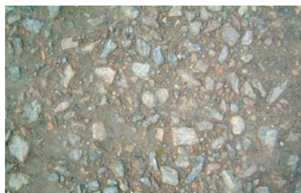
Exemple de matériau (macadam), moins "urbain" que l'enrobé, utilisable sur des surfaces de stationnement
