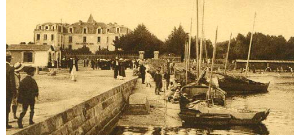
L'hôtel des Iles à Larmor-Baden. Carte postale du début du XXème siècle. L'implantation de l'hôtel était soulignée par la rade du port. Depuis la mer intérieure, l'hôtel était très prégnant et d'autant plus que ses abords étaient encore assez peu urbanisés.
