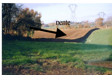
Talus antiérosion en travers de la pente
