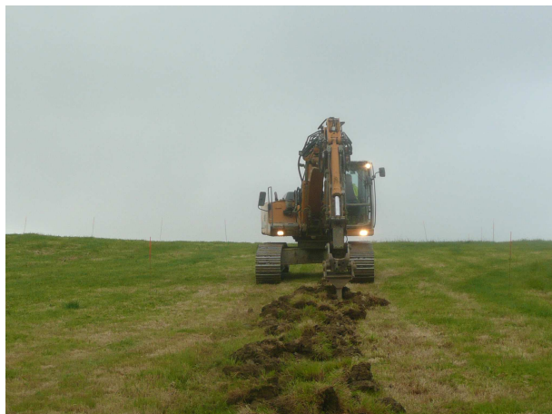
Préparation des sols (décompactage)
