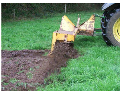
Rototrancheuse en action
