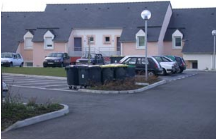
La gestion de la voiture en surface occupe beaucoup de place, et les espaces verts sont ici réduits à des reliquats engazonnés sans qualités particulières.
