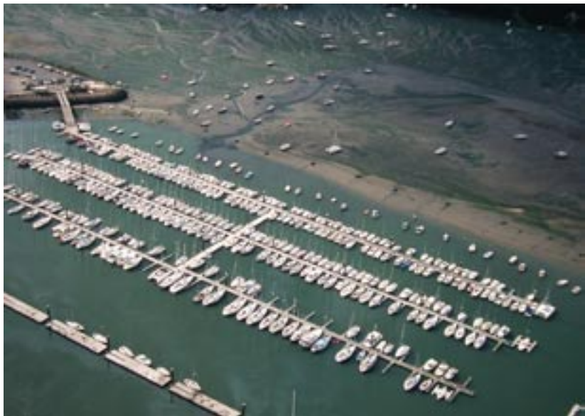
L'extension des ports de plaisance a des incidences sur les vasières, qui sont des milieux indispensables à la richesse biologique des eaux côtières.
