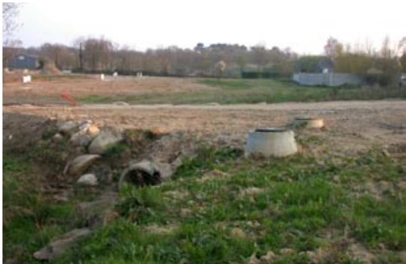
Remblaiement de secteur humide et busage de ruisseau dans un futur quartier d'habitat.
