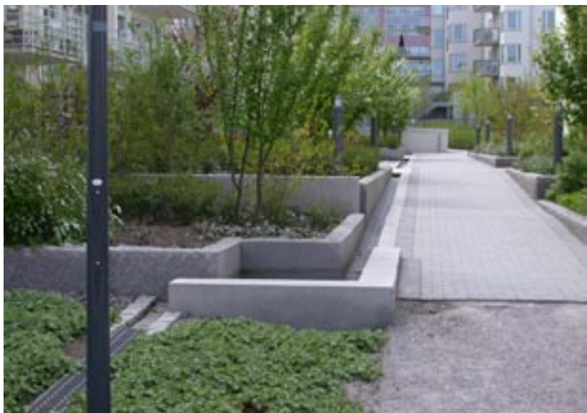
Dans ce quartier de ville, toute la circulation des eaux pluviales s'effectue à l'air libre dans des rigoles et des bassins.
