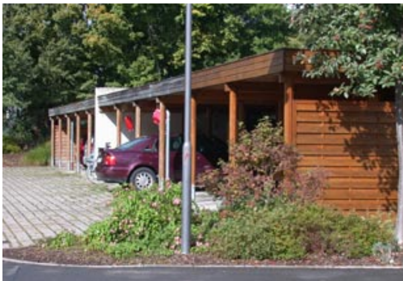
Garages collectifs sous la forme de «carports».
