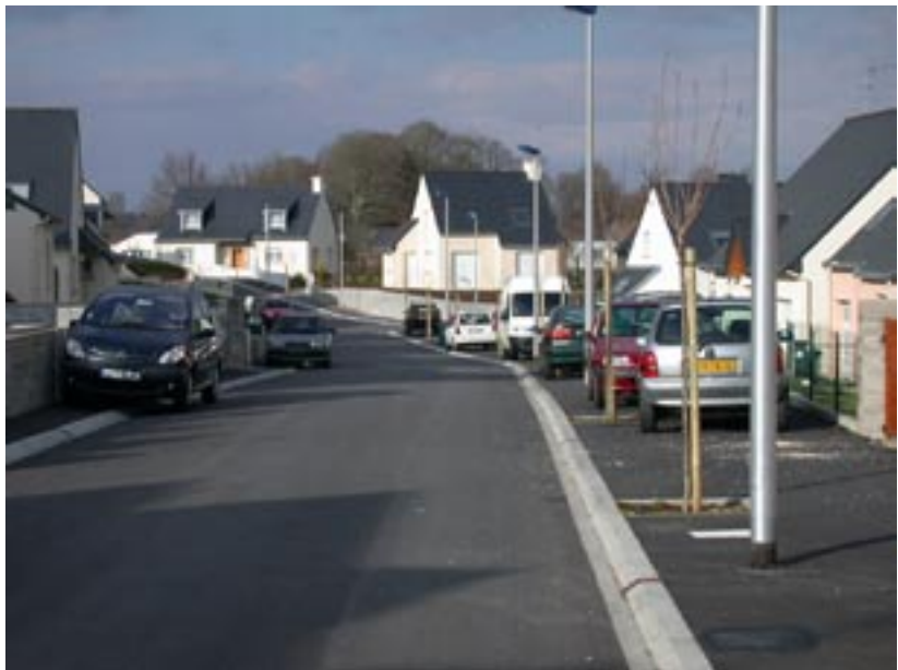
Cette voirie de lotissement est large, mais elle contraint les piétons à descendre sur la chaussée, puisque les pseudo-trottoirs servent au stationnement.
