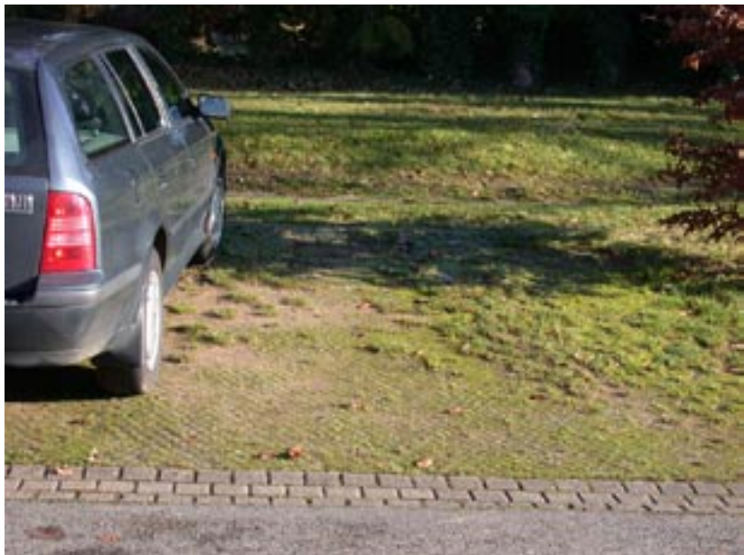
Aire de stationnement en matériaux drainants dans une zone d'activités.
