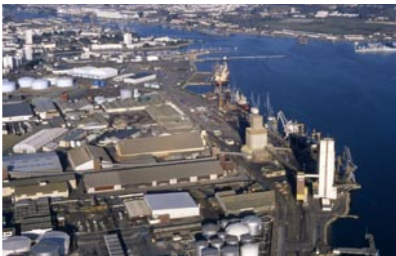
Les installations de stockage de carburants (ici sur une zone portuaire) peuvent constituer un risque industriel majeur.
