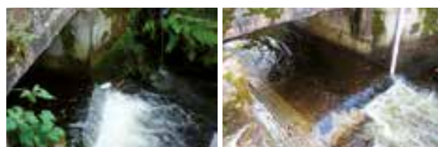
Avant et après travaux © : DDTM 29
