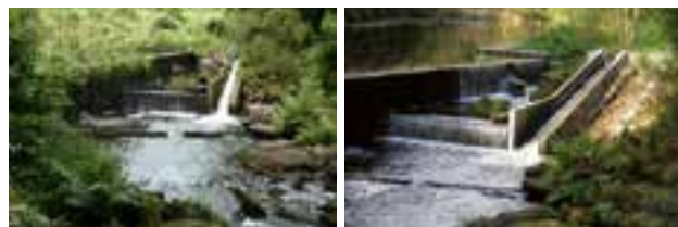
Avant et après travaux © : DDTM29
