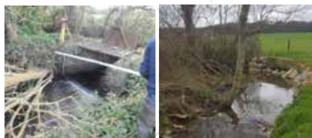
Avant et après travaux © : Syndicat du bassin du Linon
