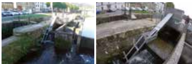
Avant et après travaux © : SMATAH
