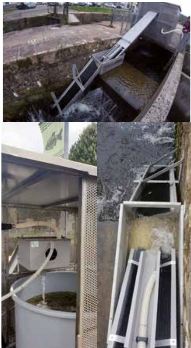
Passe à anguilles de l'écluse de Châteaulin sur l'Aulne, bac de piégeage et rampe de reptation (source : SMATAH)
