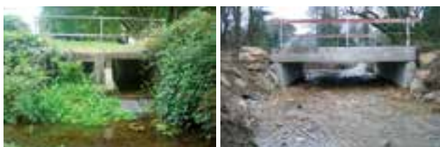
Avant et après travaux © : DDTM 29
