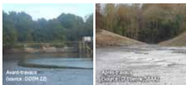
Avant et après travaux © : DDTM22 – D. Etienne, SBAA
