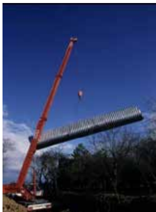
Photo 3 Pose du tunnel 1995
