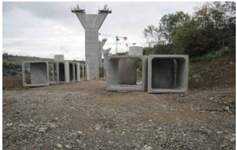
Vue des éléments préfabriqués avant le montage
