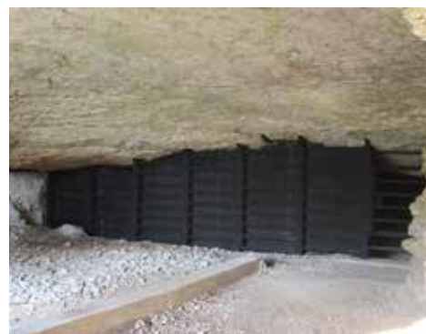
Nouvelle fermeture adaptée aux chauves-souris. Après travaux (Photos prises en février 2022)
