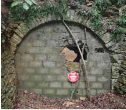
Entrée avant le chantier
