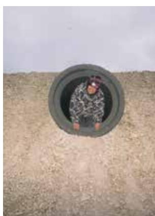
Sortie du tunnel après l'aménagement
