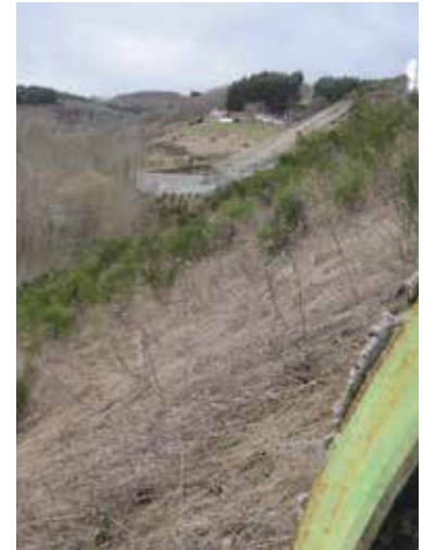
Vue du talus de l'A89 depuis l'entrée de la galerie du Boussuivre en cours de recolonisation par la végétation (février 2017).
