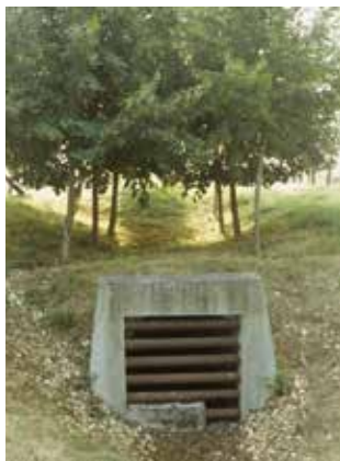
Photo 4 Grille en début du tunnel
