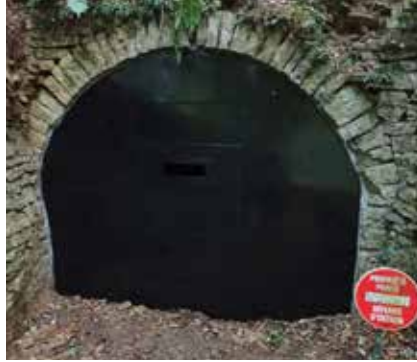
Entrée après le chantier
