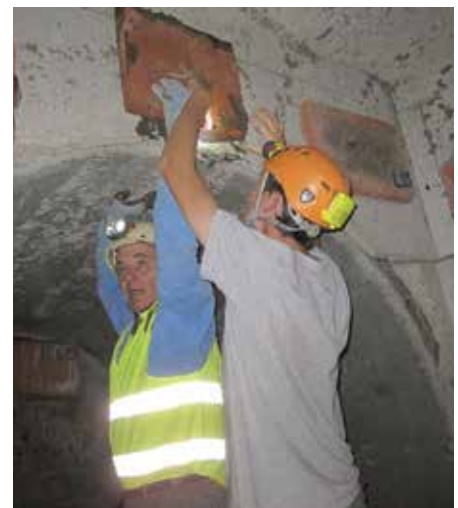
Projection de mortier et pose de briques plâtrières, poseur de briques en action
