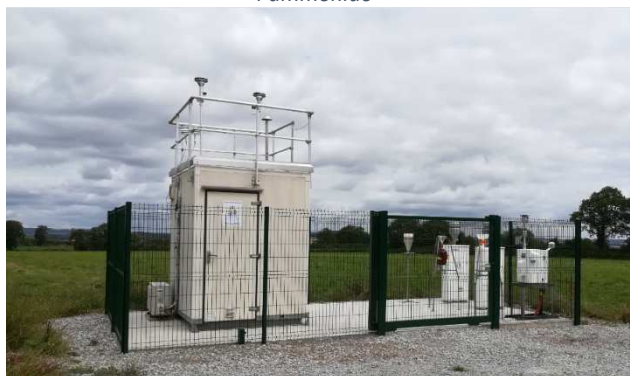
Station Kergoff équipée d'un analyseur en continu de l'ammoniac
