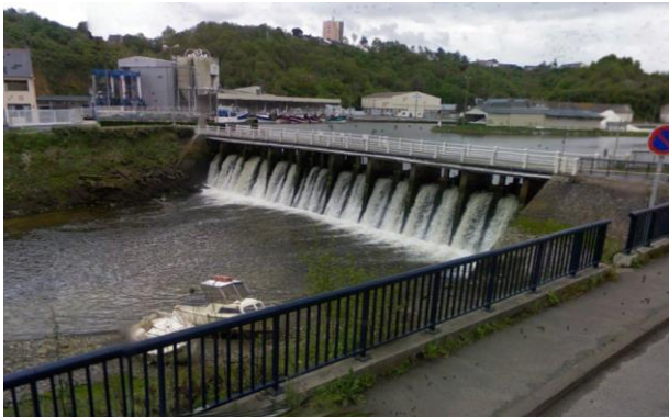
Figure 6 : Barrage déversoir (rive gauche)
