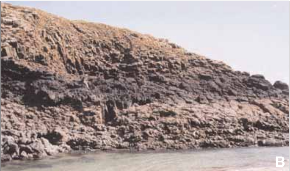
Figure 13 - Prismation de la dolérite de Kerdra. A. Observable sur le flanc nord de la pointe. B. Observable à la pointe.
