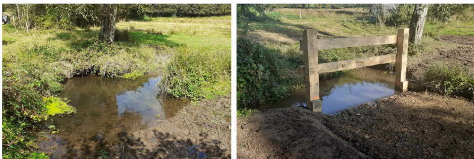
Installation d'une descente aménagée en 2020 Avant/Après - Crédits photo Saint-Brieuc Armor Agglomération
